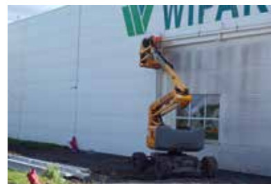
La façade de l'usine extérieure qui donne sur la départementale a été totalement nettoyée de la pollution routière.
