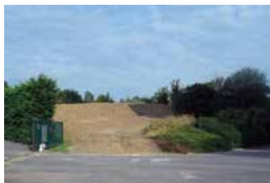
La terre décaissée a été utilisée, en concertation avec le voisinage, pour créer des « murs » qui atténuent les nuisances sonores
